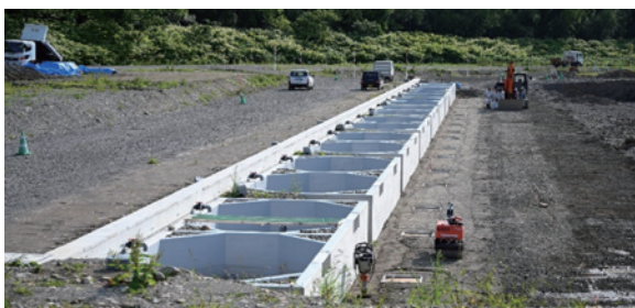
写真2. 建設した屋外水槽。写真右側にさらに屋外水槽が三列、左側には飼育用水の昇温のための貯水池が建設される予定である。
